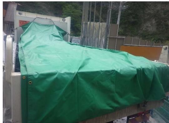
写真 6-2-12 運搬時の浸透防止シート設置状
