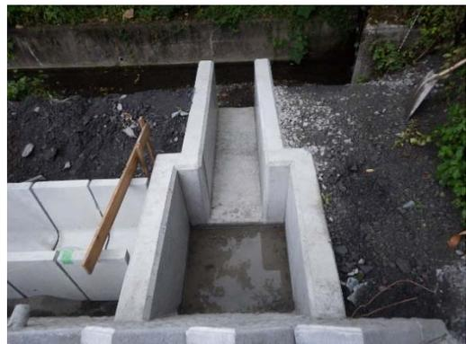
写真 6-3-6 沈砂池の設置
