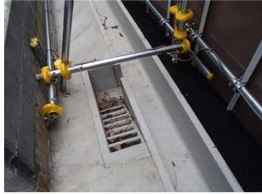
写真 6-1-12(1) 小動物が脱出可能な側溝
