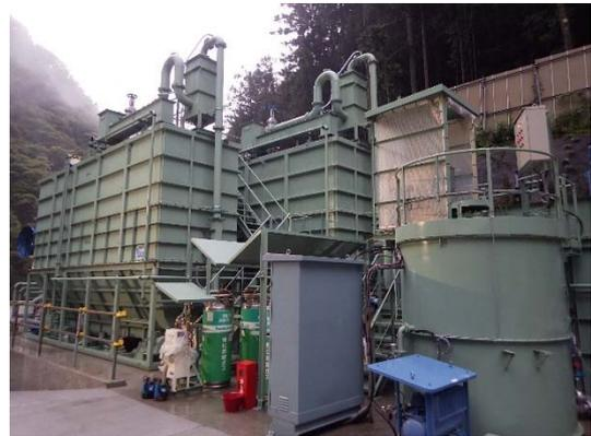
写真 6-2-10 濁水処理設備
