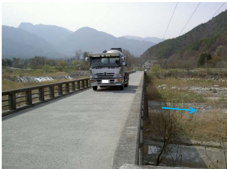
【写真①】 現道の状況 (幅員狭小)
