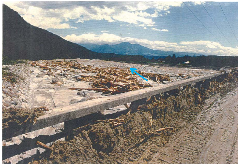
【写真③】 洪水時の状況 (昭和57年8月 台風10号)
