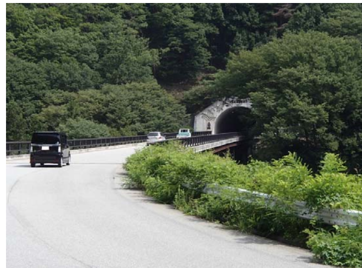
【写真④】 既整備箇所の状況（大渡バイパス（新紅葉橋・鳥居坂トンネル））
