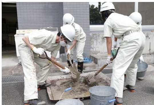
コンクリート実習
