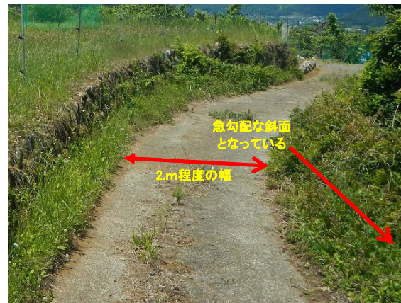
幅員も狭く湾曲した耕作道(路肩を踏み外すと転落の危険あり)
