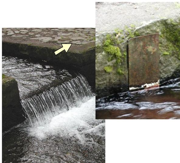
図4 導水路とその側壁に取り付けた水位板
