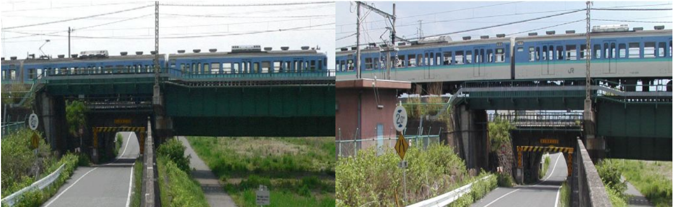
図5 富士見の騒音レベルに影響を及ぼした線路の構造(写真 左：下り、右：上り)
