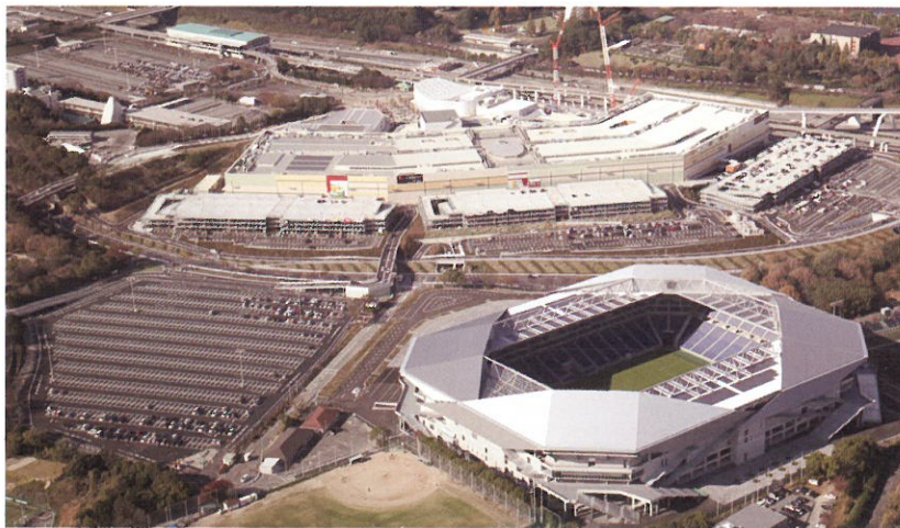
大型複合施設と隣接する市立吹田サッカースタジアム。写真左上の青い屋根が万博記念公園駅
