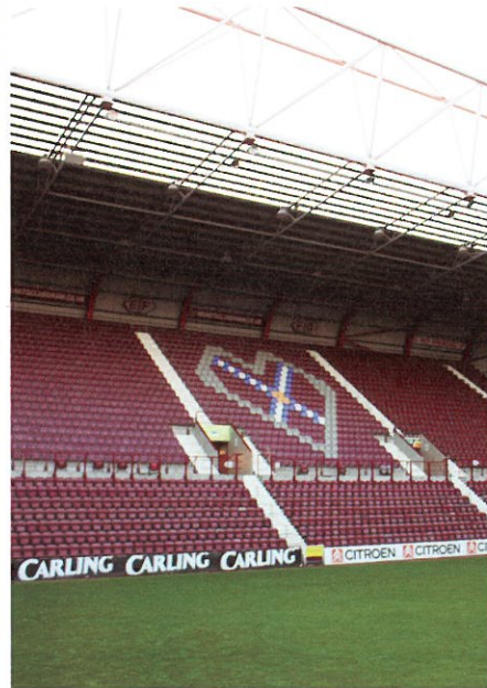
スタンドの傾斜角がピッチを近づける。最大で40度のところも(エジンバラ)
