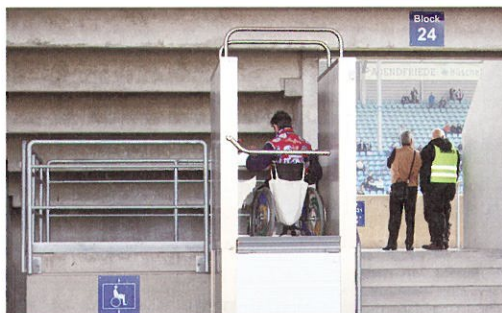
車椅子用の専用リフトが稼働中(マクデブルク)
