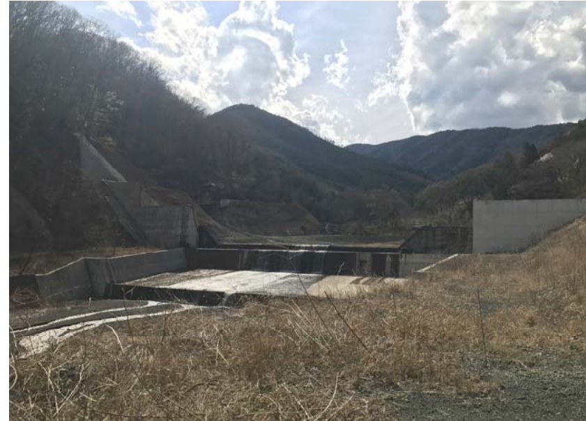
②堰堤工（不透過型）（施工中）
