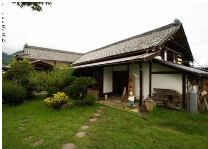
外観（主体部）切妻屋根
