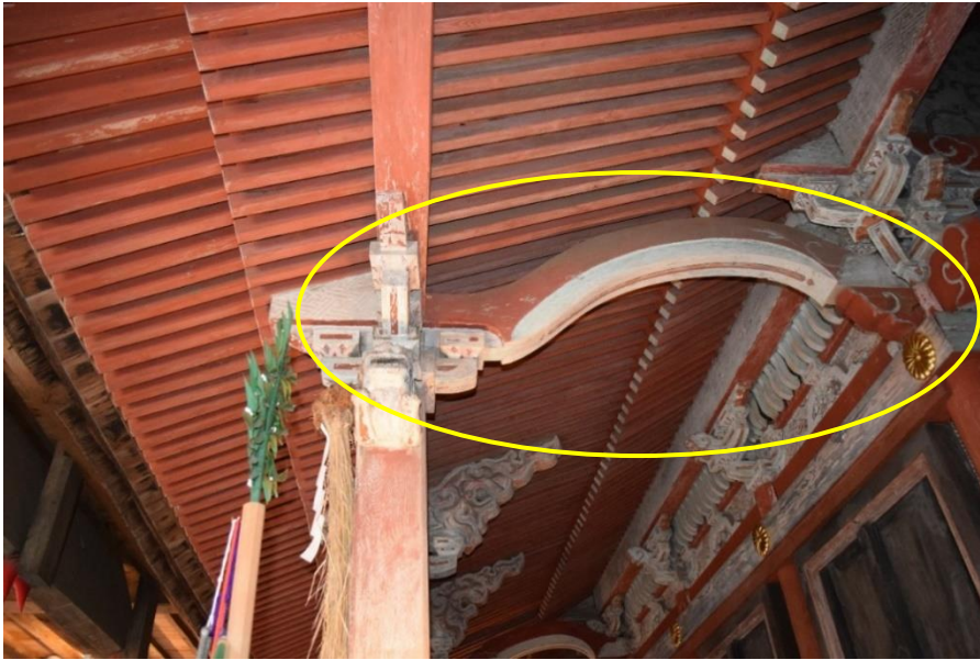
本殿向拝蝦虹梁
