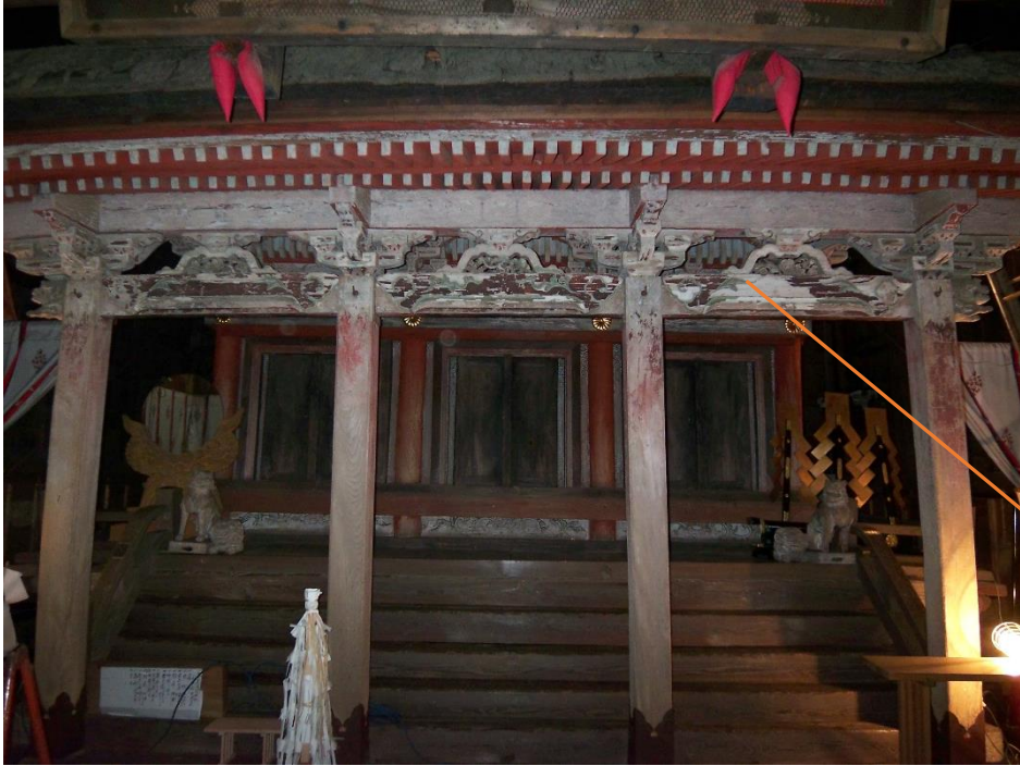
本殿向拝 (正面)
