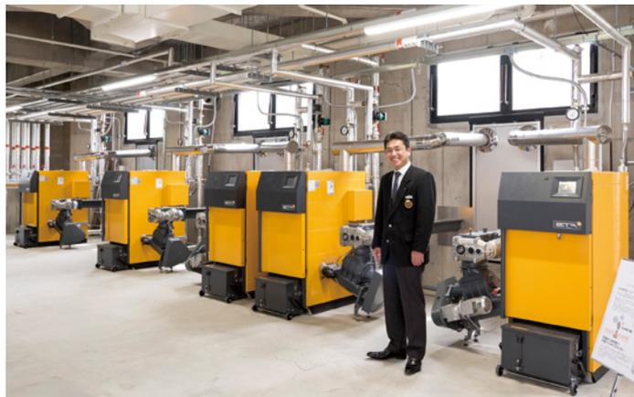
オーストリア製のボイラー5台で、クラブハウス内の入浴施設やレストランなどの給湯を賄っている
