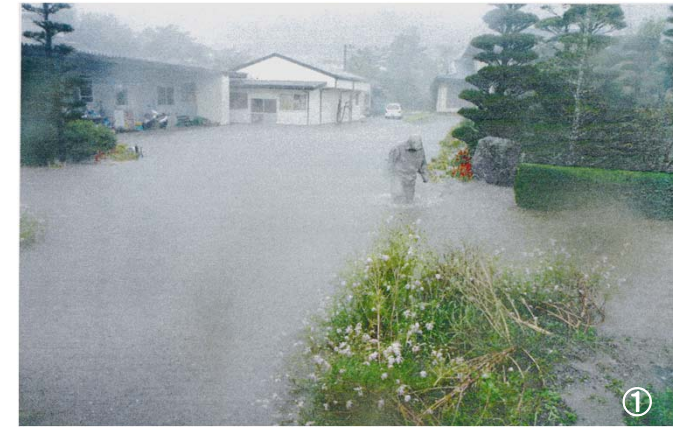
溢水状況 H23.9.21 (台風15号)
