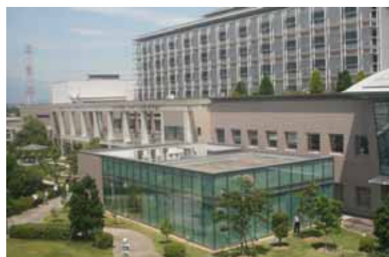
市立甲府病院の外観
