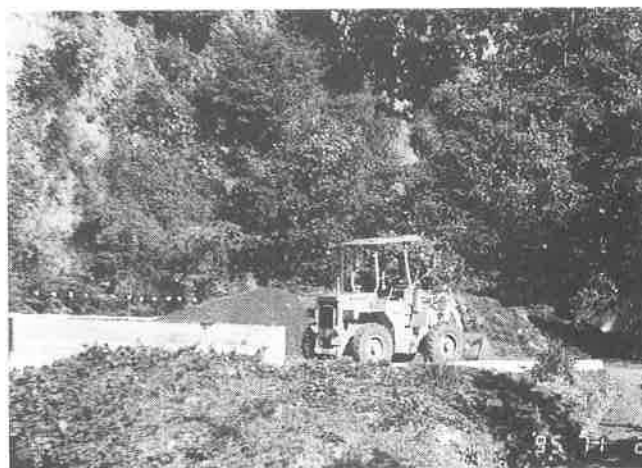
写真1 御坂実験場の全景
