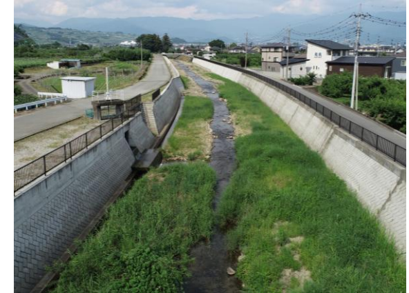
笛吹市 河川整備（平等川）
