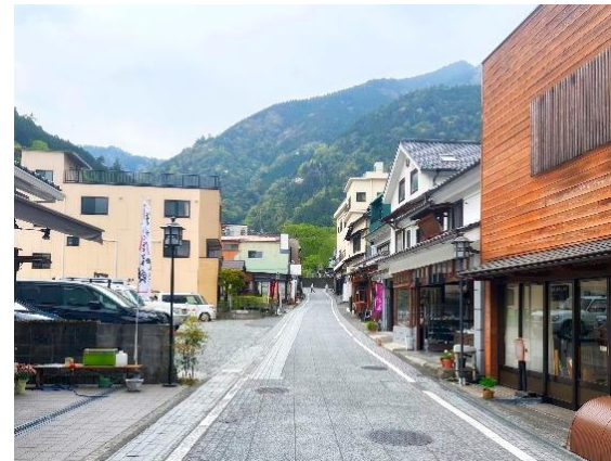
身延町 電線共同溝整備（身延山門内）
