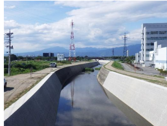
甲府市～中央市 河川整備（鎌田川）
