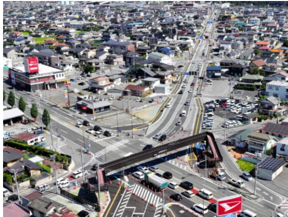
甲斐市 街路整備（田富町敷島線）
