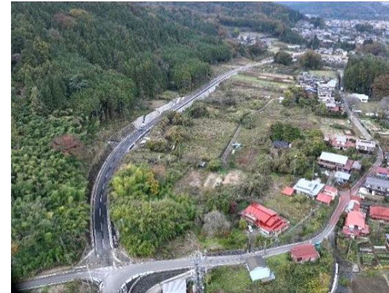
大月市 道路整備（梁川猿橋線太田バイパス）
