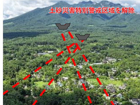
北杜市 砂防堰堤整備（古杉西沢）
