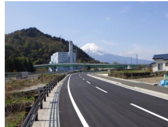
西桂町 道路整備（富士吉田西桂都留線小沼バイパス）
