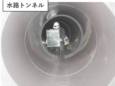
水路トンネル
