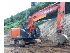
ICT技術を搭載した重機
