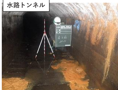
水路トンネル
