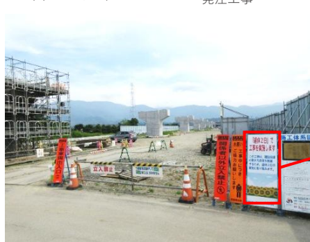
週休2日制対象工事の現場状況
