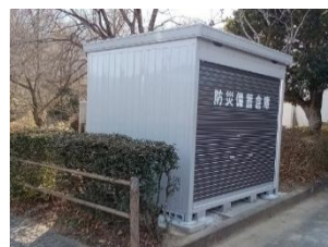
防災倉庫（富士川クラフトパーク）
