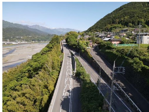
（主）富士川身延線（井出工区）（南部町）
