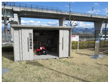
道の駅しらね（防災備蓄倉庫、防災井戸）
