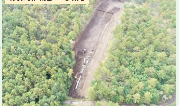
浅間沢施工状況
