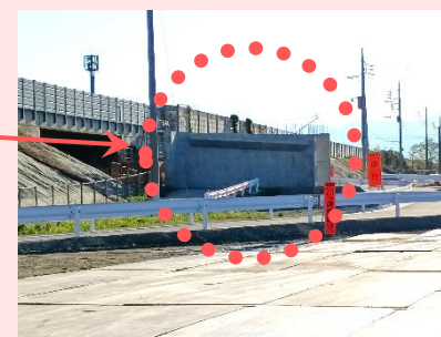
ランプ橋下部工工事
