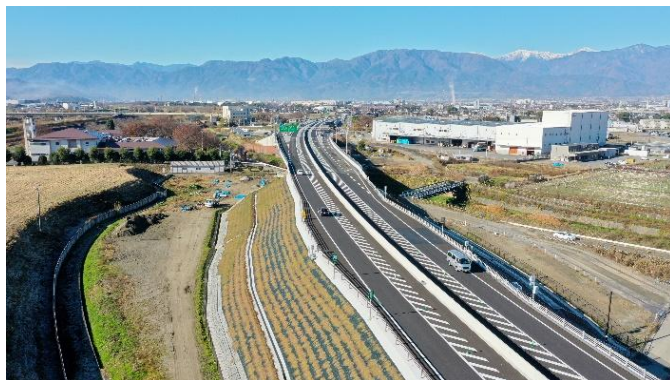
新山梨環状道路（東部区間Ⅰ期）（甲州市）
