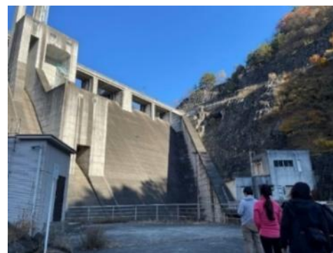
ダム堤体下でのドローン飛行
