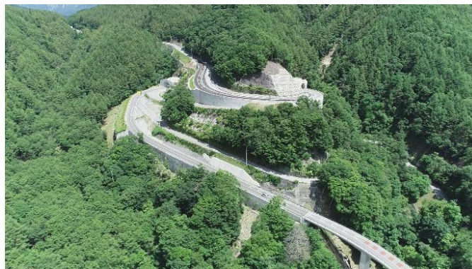
国道411号（上萩原Ⅲ期バイパス）（甲州市）
