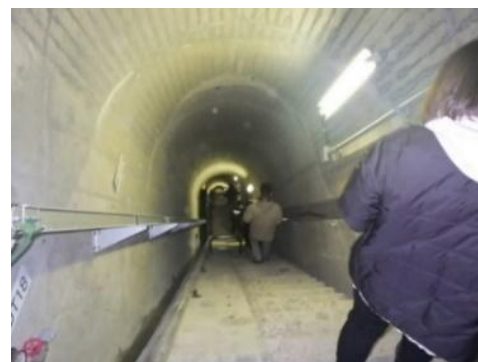
監査廊の見学
