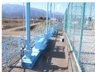
横川水門（河川メンテナンス） 巻上機防食性能向上
