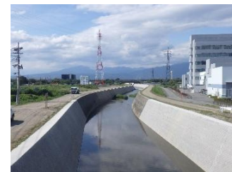
鎌田川（河川改修）
