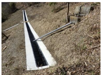
湯の岡台（地すべり対策）水路修繕
