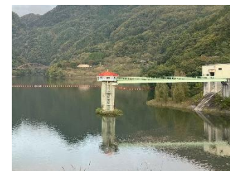
荒川ダム（堰堤改良） 取水塔防食性能向上
