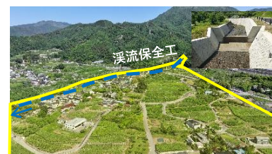
天川（土石流対策）
