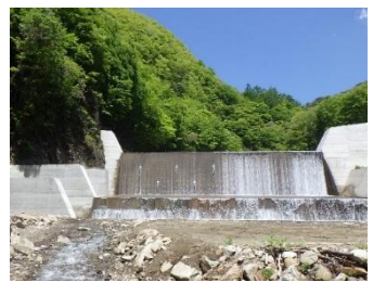
日川（土石流対策）堰堤改良
