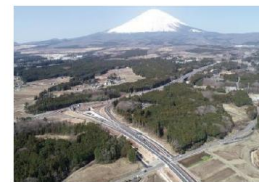
国道138号（須走道路・御殿場バイパス） 令和3年4月10日供用開始
