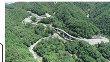
国道411号（上萩原III期バイパス） 令和3年8月供用開始
