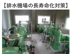
上野排水機場
