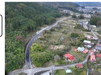
(一) 梁川猿橋線（太田バイパス） 令和6年12月供用開始
