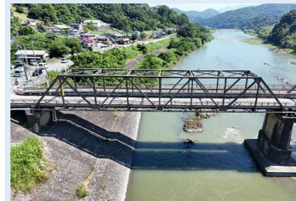
（一）下部飯富線 飯富橋
