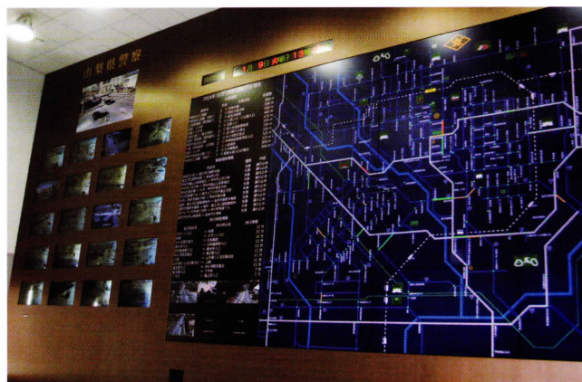
交通管制センター
