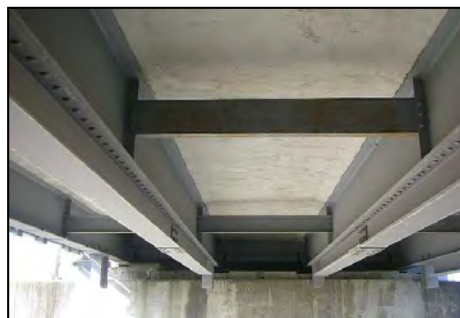
写真 2-7 主桁断面増加
