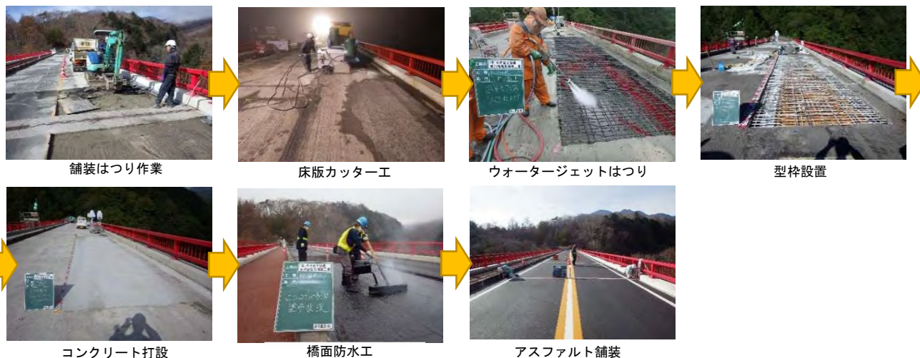
コンクリート打設
