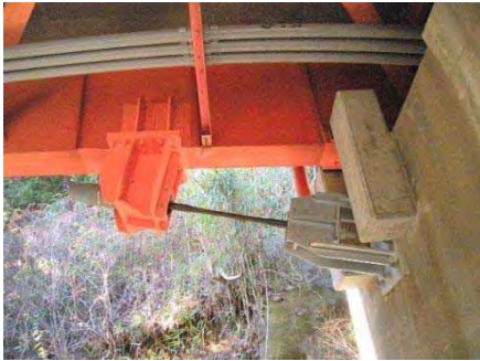
写真 2-3 落橋防止装置(連結ケーブル形式)
