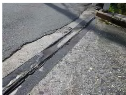
写真 1-2 伸縮装置 (変形欠損)
