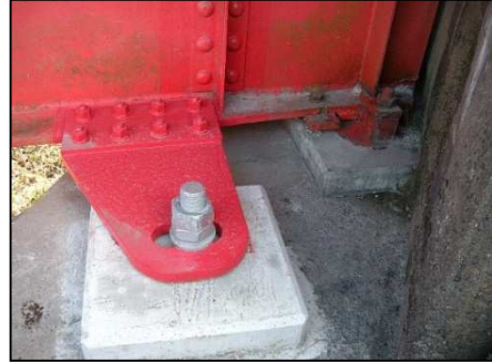
写真 2-4 変位制限装置(ピン形式)
