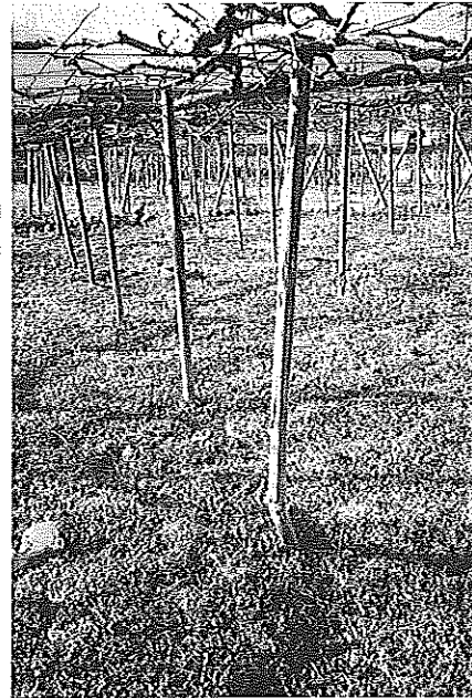
写真-4 作業用機械の接触で折損したと思われるコンクリート製束杭
