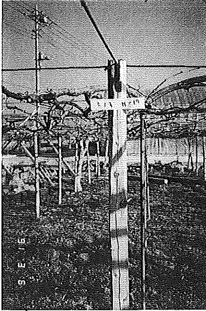
写真-7 ヒノキ束杭（温冷浴処理）の 頂端部の状況
