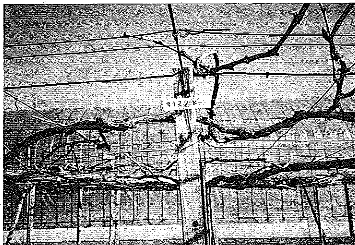
写真-2 カラマツ心持材の束杭の頂端部、全体としてはねじれているが、針金の脱線などはない
