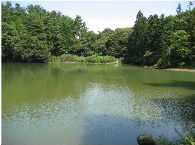
① ため池の全景
