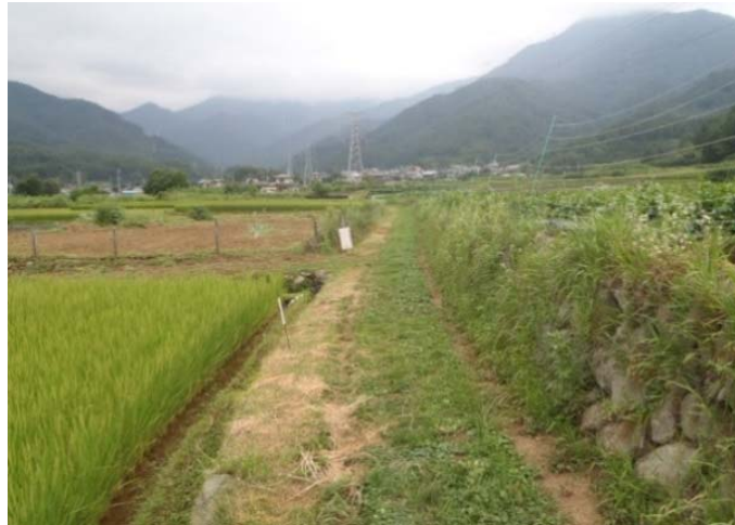
①農道の幅員が狭小で、農作業に支障をきたしている。
