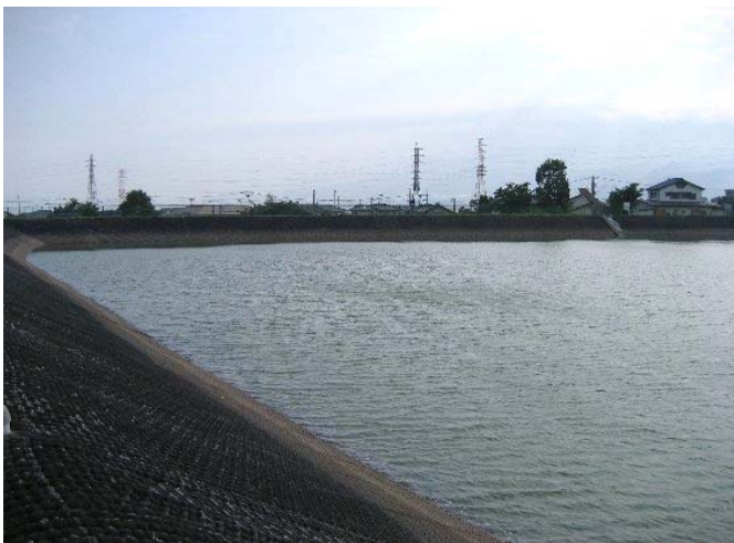
① ため池の全景
