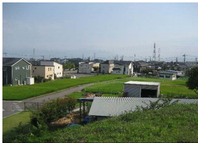
④ ため池下流の状況。 堤体直下には人家があり、大規模地震の際には甚大な被害のおそれがある。
