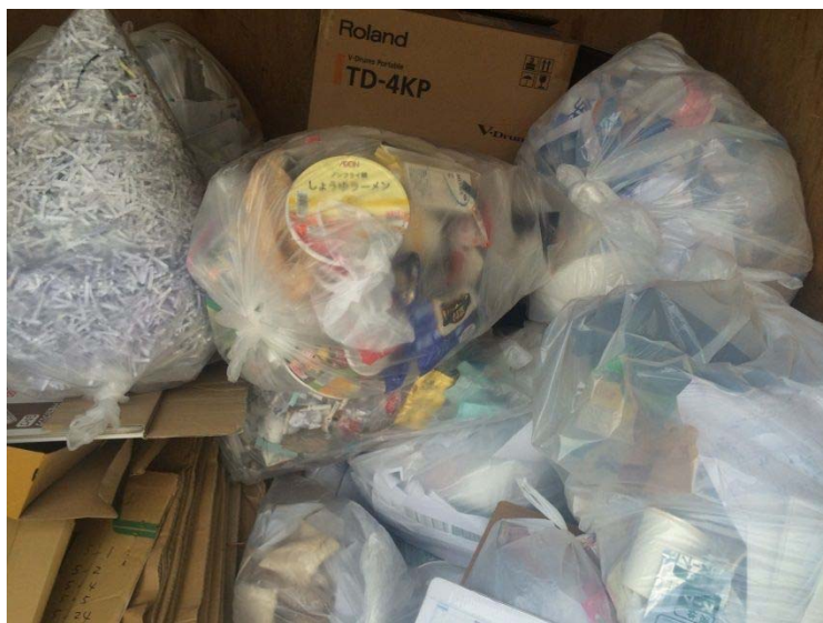
ごみ処理施設工事におけるごみの分別・管理の状況（保管倉庫内の状況 拡大）
