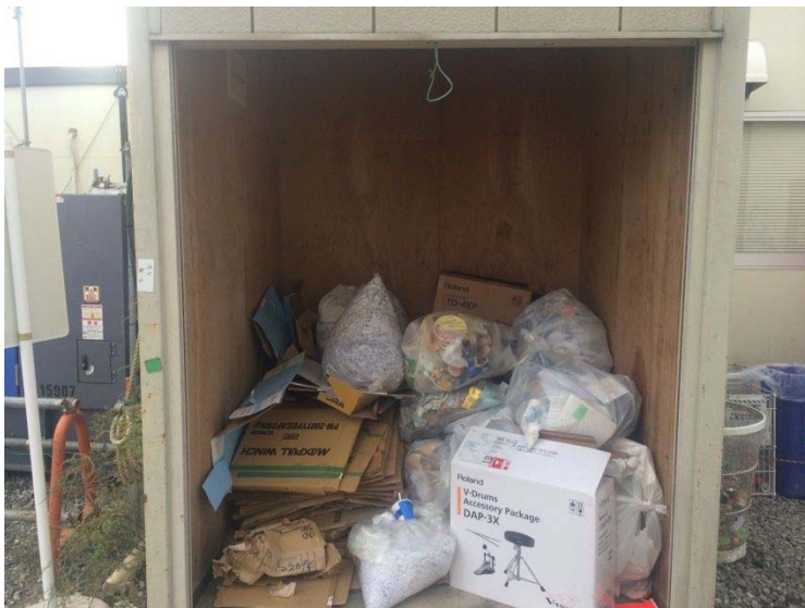
ごみ処理施設工事におけるごみの分別・管理の状況（保管倉庫内の状況）
