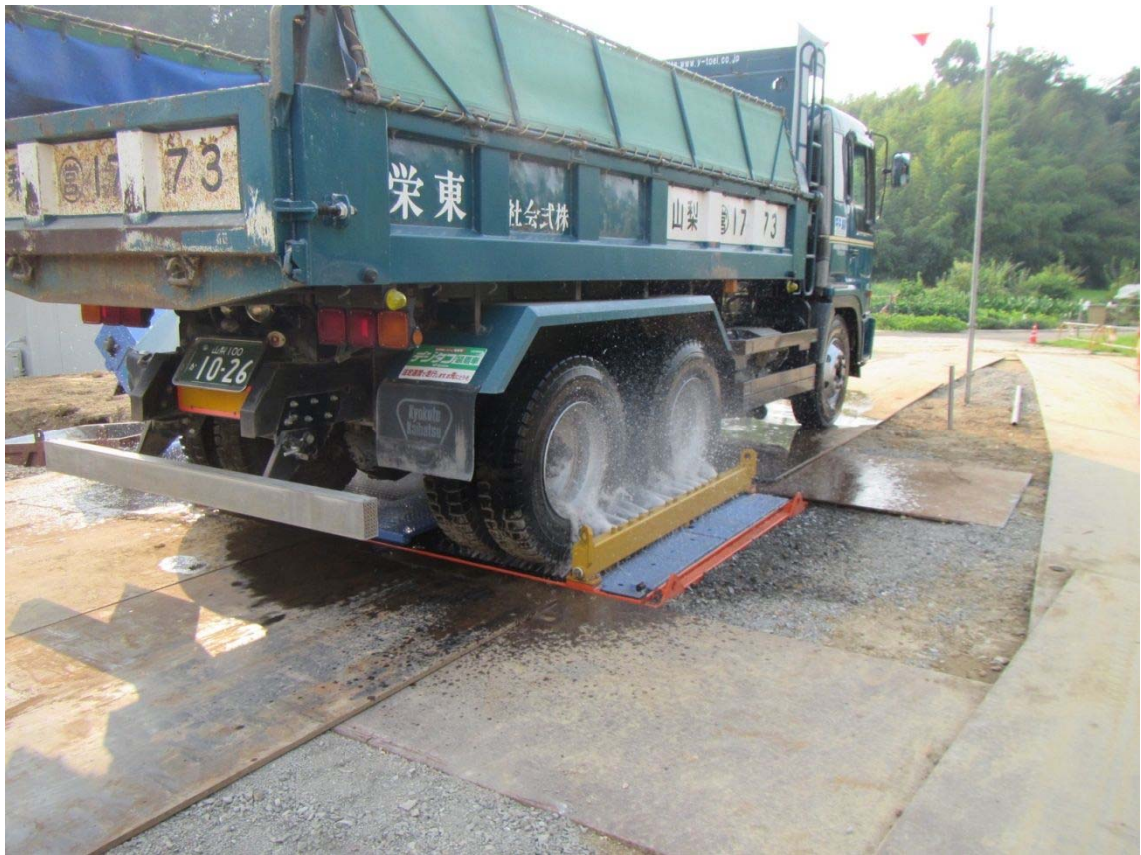
車両タイヤ洗浄状況
