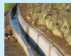
■ 素掘り水路からコンクリート水路への更新
