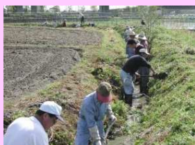
■ 水路の保全管理
