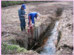
■ 点検・機能診断
