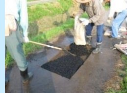
■ 農道舗装の補修
