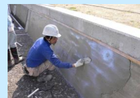
■ 水路の老朽化箇所の補修
