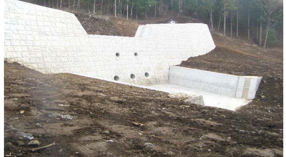
②不透過型堰堤 (施工済)
