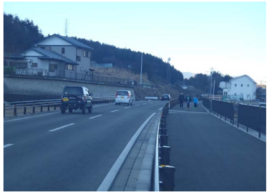
④ 小沼1工区 供用済区間
