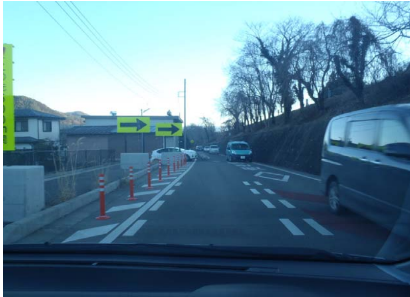
① 小沼2工区 起点部
