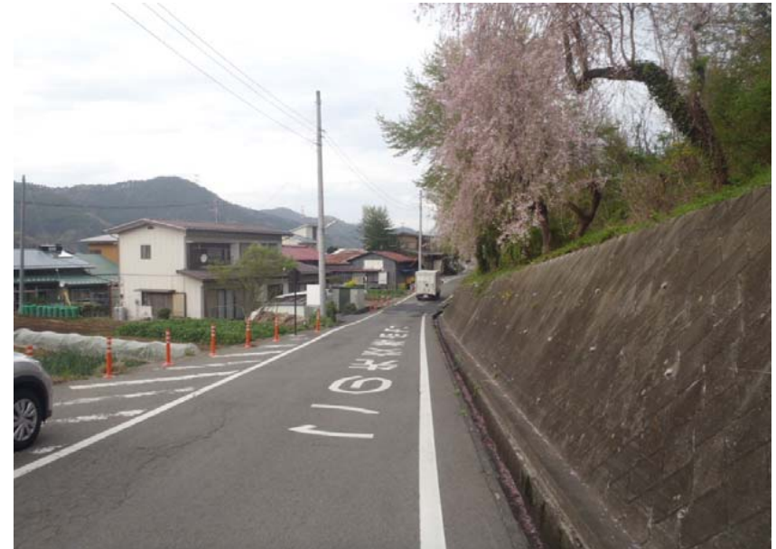
② 小沼2工区 拡幅区間
