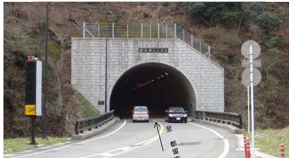
④ 新トンネル内
