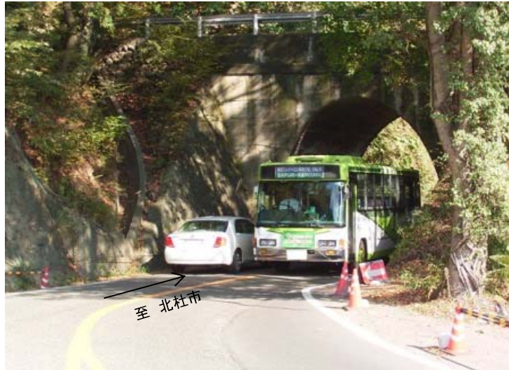
① 旧道部(青坂隧道)での過去の通行阻害状況
