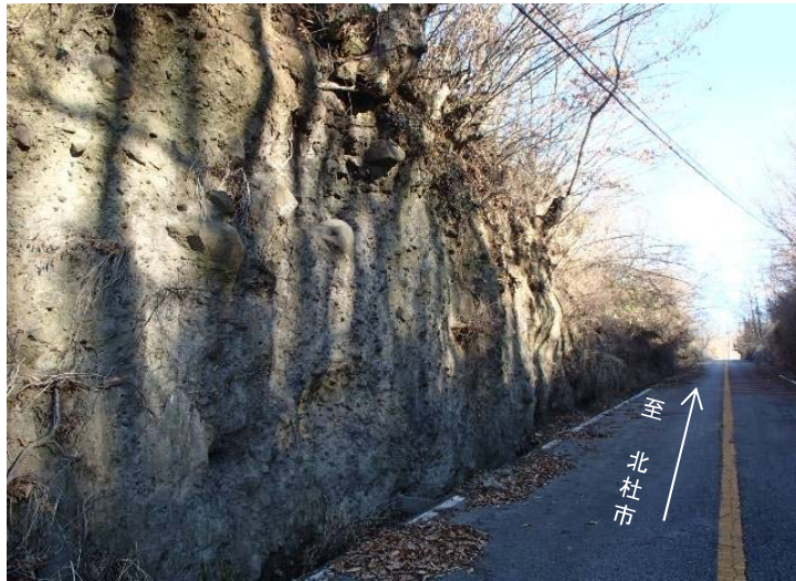
② 旧道部の法面状況(現在、通行止め)
