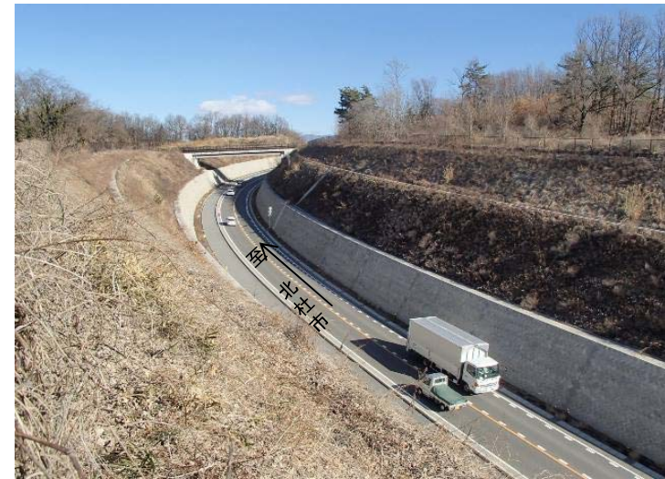
④ バイパス部の法面と大型車の円滑な通行状況
