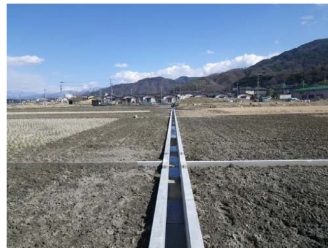
完成後 水路整備により安定した用水が確保されると共に、溢水による被害も防止されている。
