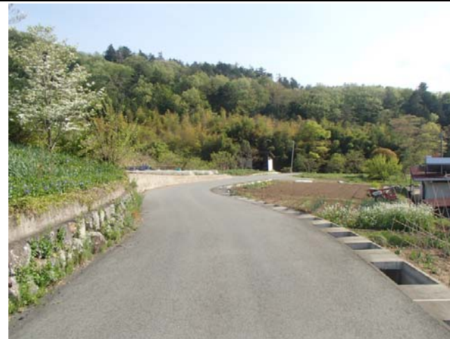
完成後 農道の整備により、農耕車が容易に進入できると共に、すれ違いが可能となるなど、安全性と農作業の利便性が向上している。
