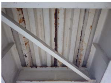
(1)田富歩道橋 防食機能の劣化(健全性) (2)北新歩道橋 剥離・鉄筋露出(健全性) (3)三富小学校前歩道橋 腐食(健全性)
