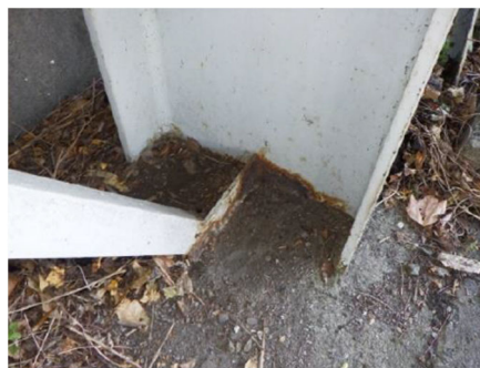
(2) 柱基部の腐食（健全性Ⅱ） 峡南第3ロックシェッド：甲斐岩間停車場西島線
