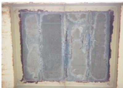
(1)田富歩道橋 防食機能の劣化(健全性) (2)北新歩道橋 剥離・鉄筋露出(健全性) (3)三富小学校前歩道橋 腐食(健全性)
