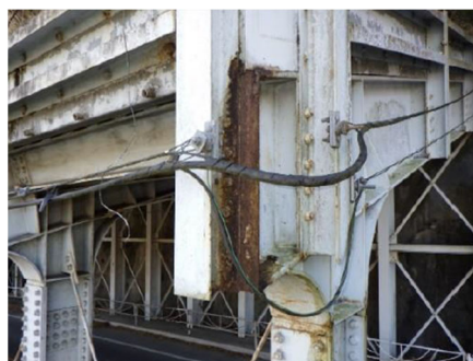
(4) 主梁の腐食（健全性Ⅱ） 峡南第3ロックシェッド：甲斐岩間停車場西島線
