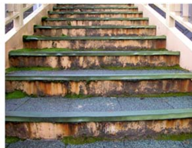
(1)田富歩道橋 防食機能の劣化(健全性) (2)北新歩道橋 剥離・鉄筋露出(健全性) (3)三富小学校前歩道橋 腐食(健全性)
