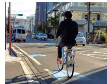
(主)甲府山梨線矢羽根型路面標示
