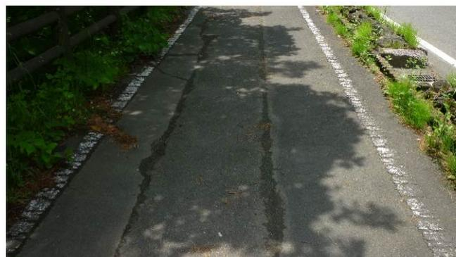
図- 4.13 老朽化による舗装損傷
