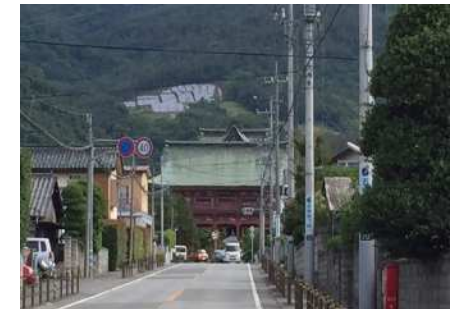
歴史的文化財の背景の山腹の斜面に設置された太陽光パネル
