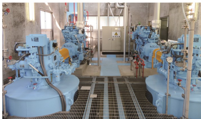
西嶋地区 西嶋排水機場工事
