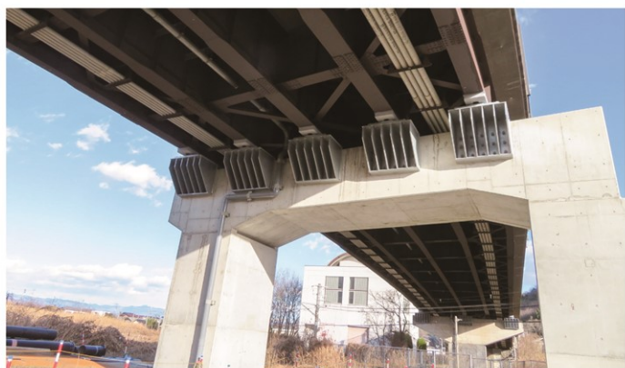
広域農道(市川大門高架橋)の耐震補強工事
