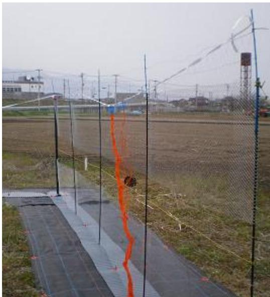
結束バンドでネットを上段の針金に固定していく。下段ラスの上端にも固定する。ネットは風になびくため、固定箇所は多めにする。
