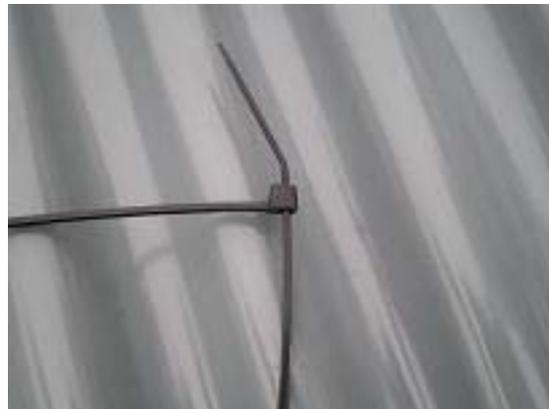
下段を終えたら、上段のラスを張る。二人一組で、一人がラスを持ちもう一人が支柱に固定していく。腕が疲れるため、適時交代して作業を行う。
