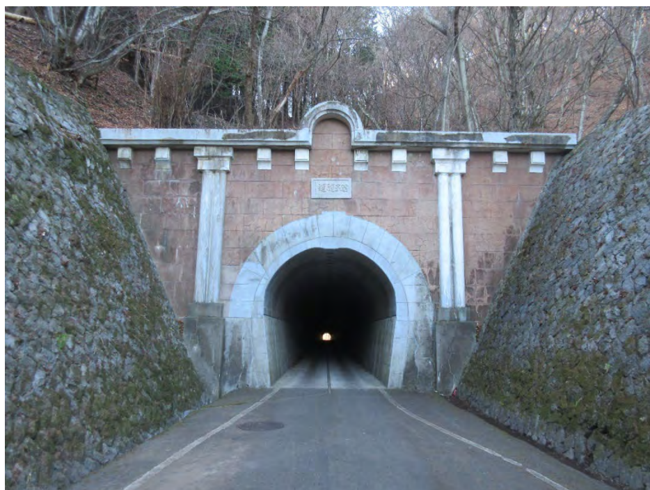
日影笹子線（県道 212 号） 笹子隧道
