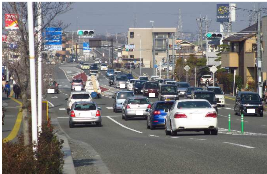
写真 整備済み状況 (起点側から中央病院東交差点を望む)
