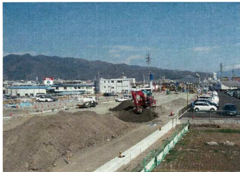
写真 整備中状況 市道富士見通りから西側区間
