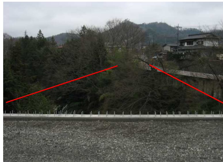
新院辺橋左岸側橋台から
