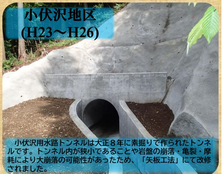
小伏沢用水路トンネルは大正8年に素掘りで作られたトンネルです。トンネル内が狭小であることや岩盤の崩落・亀裂・摩耗により大崩落の可能性があったため、「矢板工法」にて改修されました。
