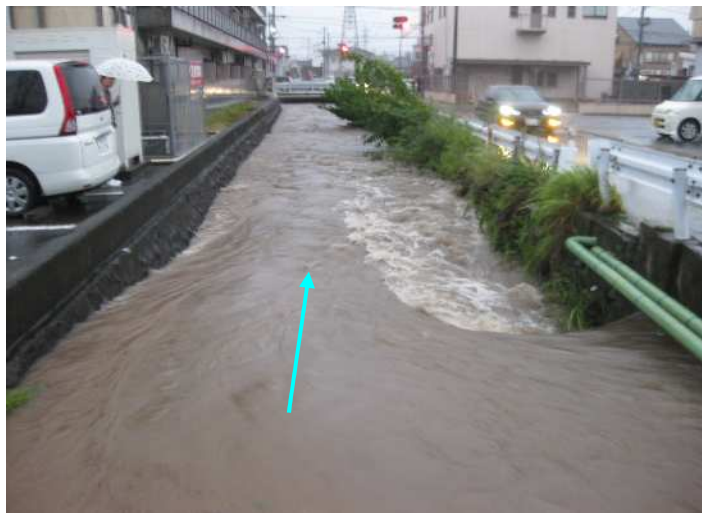
国道上流 未改修区間
