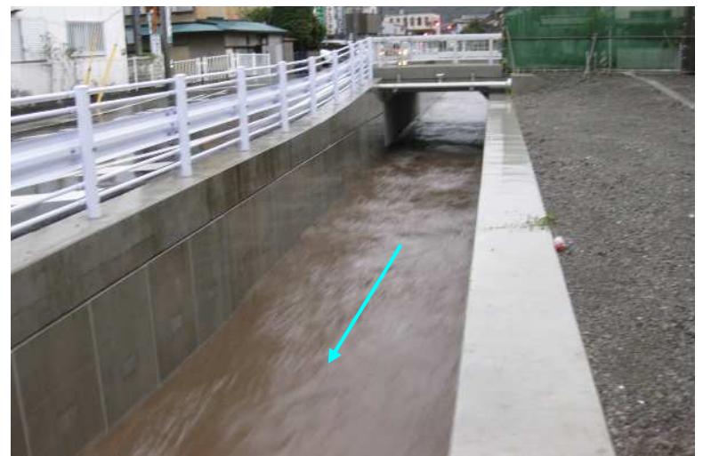
国道下流 改修済み区間
