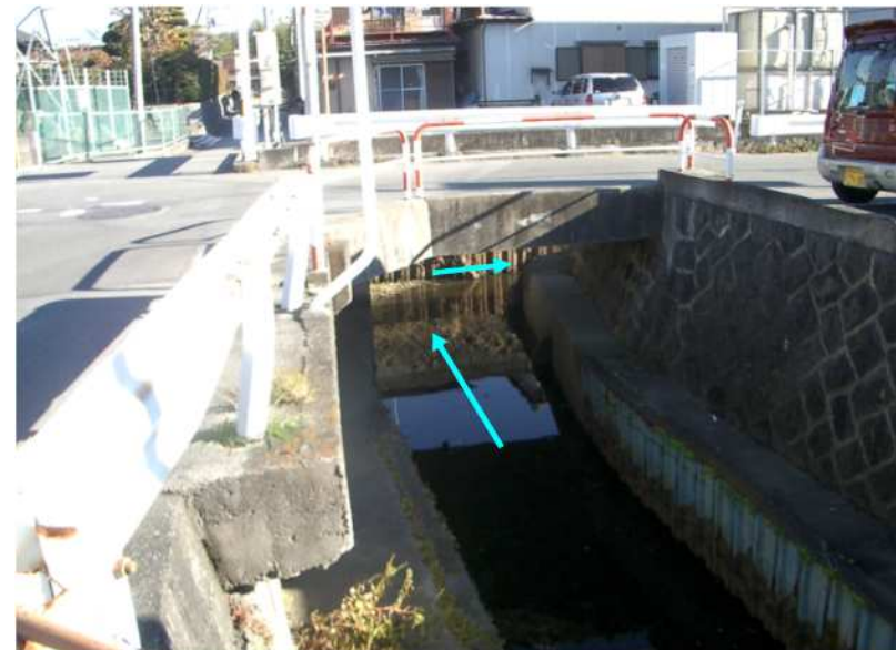
写真 屈曲部の様子 (下流端から約400m地点)
