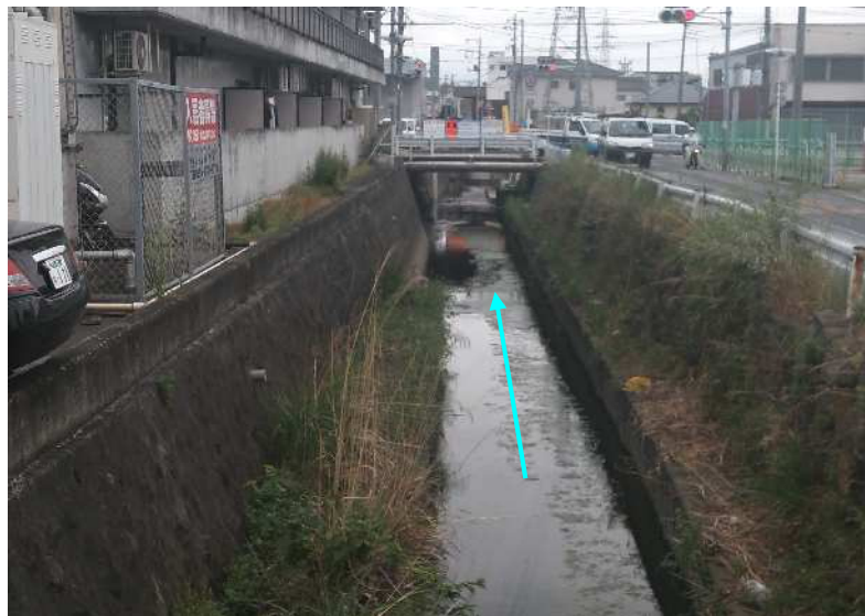
写真 (屈曲部より下流側藤川橋の様子)
