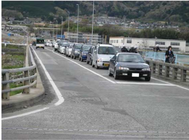
① 橋梁拡幅 (武田橋) 改良前
